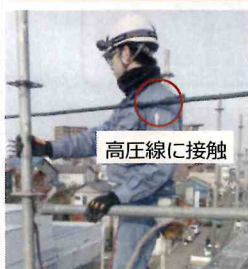
低圧引込線に接触
