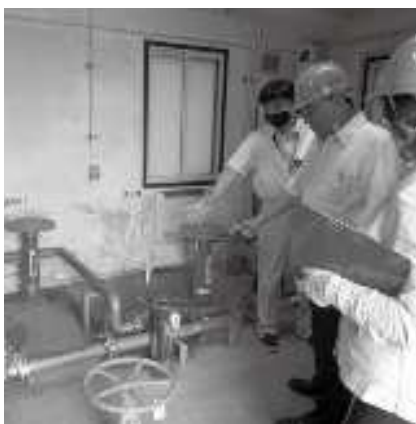
安定的な給水には、計画的な設備更新が必要
