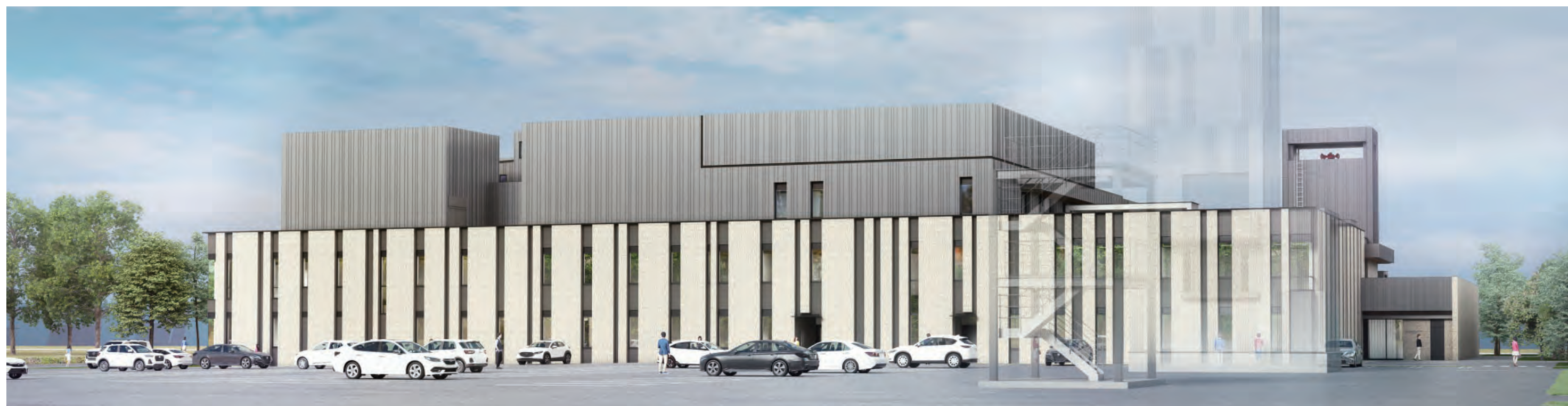
敷地北西より
