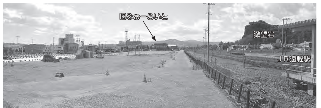
▲町道南1丁目中通、町道鉄道沿線通、コミュニティ広場駐車場の舗装や街路樹、街灯が撤去された様子
