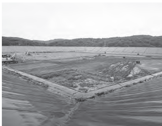
▲岩見沢市のオープン型最終処分場
