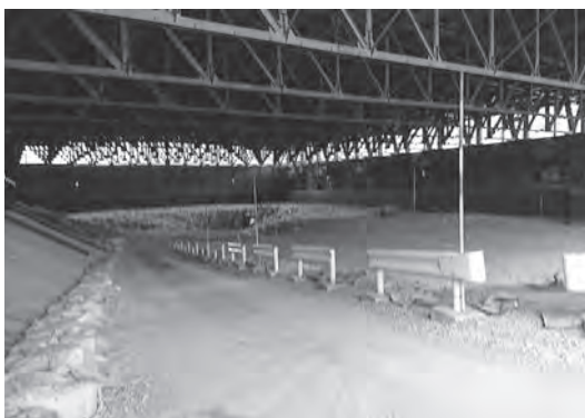
▲留萌南部衛生組合のクロード型最終処分場
